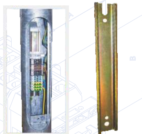
Umístění svorkovnice ve stožáru
